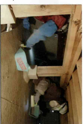
床下に入るときは安全確保のため、 換気をし、2人以上で作業をします
