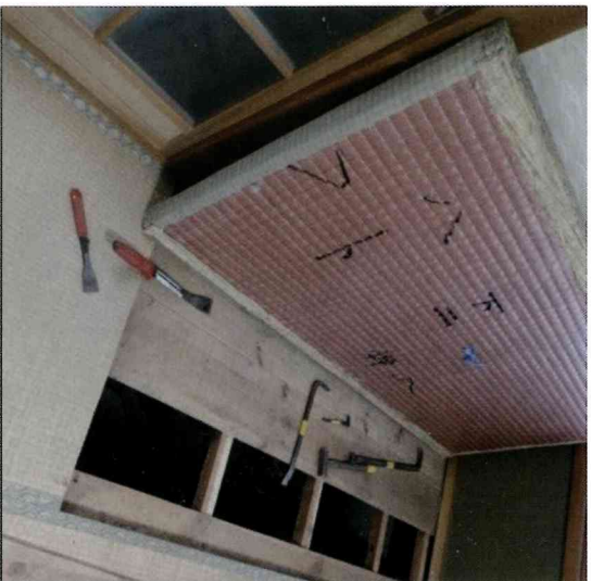
和室の床板をはがす (写真①)
