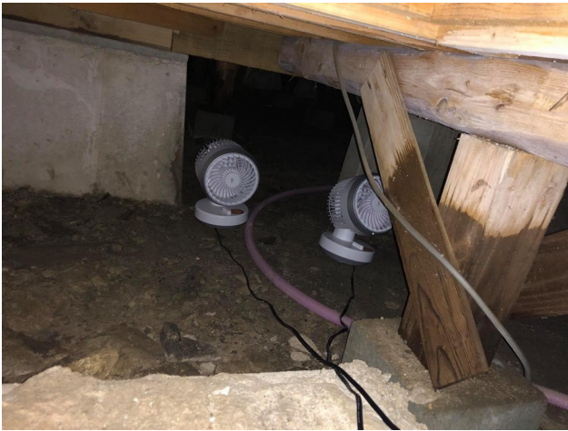
袋小路の基礎に2台で対流をつくる
