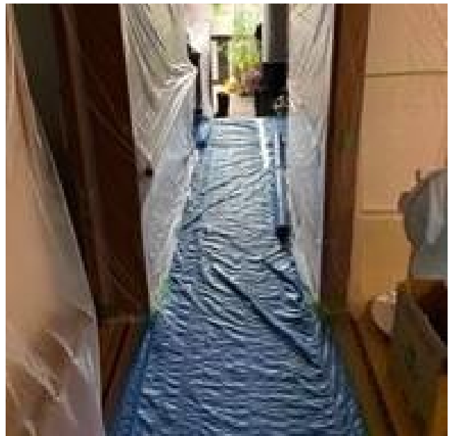
養生の例2 | 廊下は壁面も含めて全面を覆う
