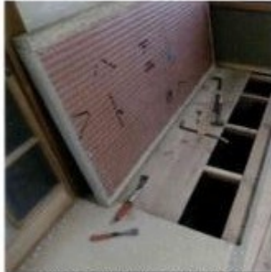
和室の床板をはがす(写真①)
