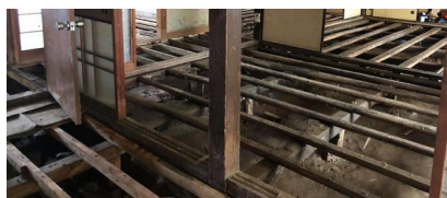
昔の家の床下 基礎がなく通気性は良い
