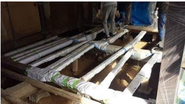
養生の例1 | 根太・大引を一本ずつ包み、動線を確保する
